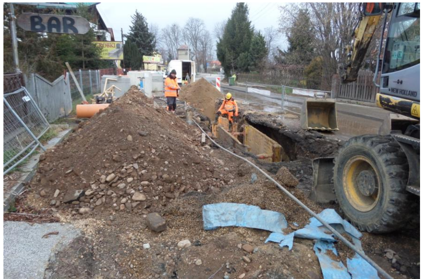
Prace przy budowie kanalizacji deszczowej na III etapie przebudowy.
