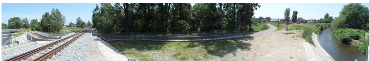
Droga rowerowa od ul. Kraszowickiej do kładki pieszo-rowerowej( realizacja 2018-2019)
