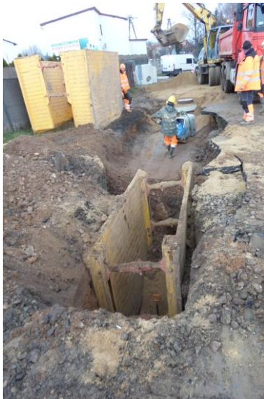
Prace przy budowie kanalizacji deszczowej na III etapie przebudowy.
